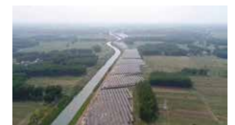
▶ 安徽临泉吕寨20MW扶贫光伏电站
